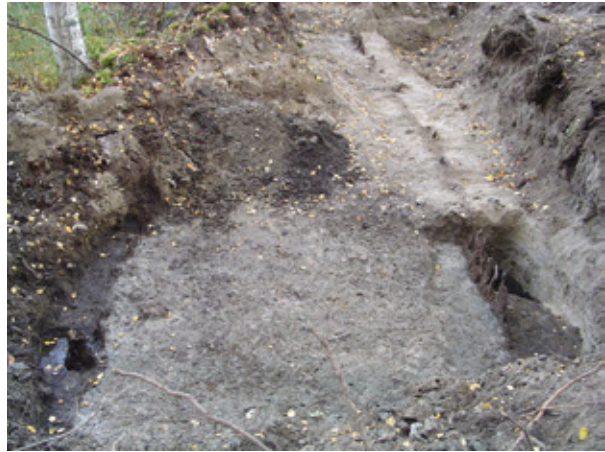
Kuva 2. Lautalinjojen välissä on käytetty selvästi savisempaa maata kuin muualla aallonmurtajissa. Kuvaussuunta: SW-NE.
