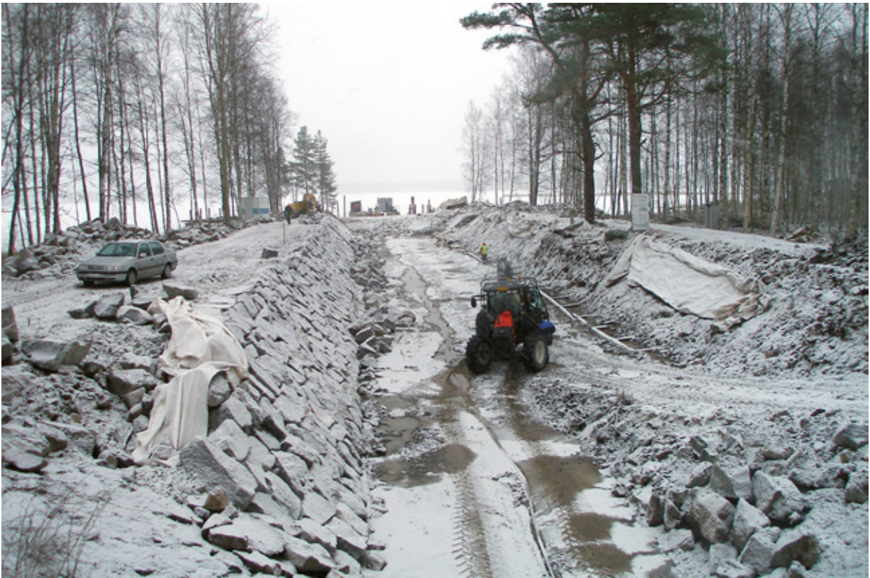
Telataipaleen kanavan restaurointityömaa vuonna 2006.
