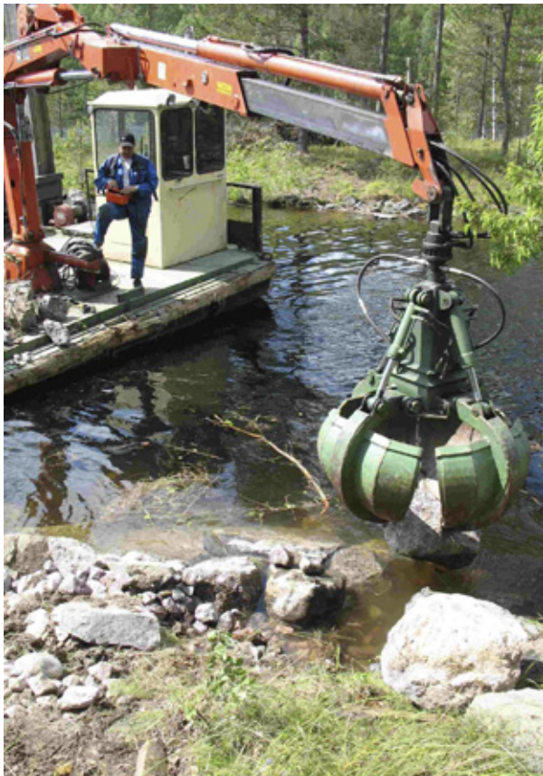
Kukonharjulla kiviä aseteltiin paikoilleen lautan päältä.
