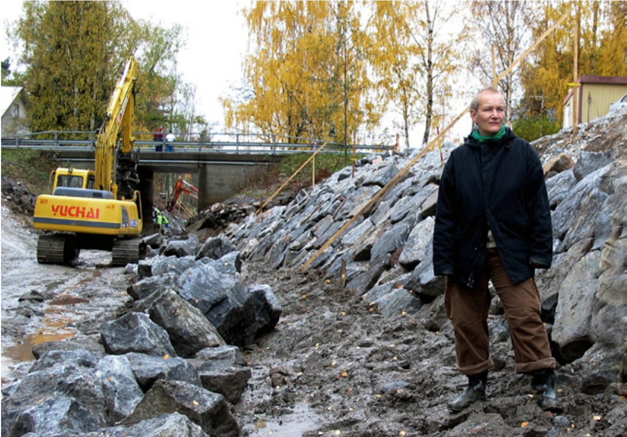
Restaurointihankkeen vetäjä arkkitehti Tuula Hakala Telataipaleen kanavalla syksyllä 2006.
