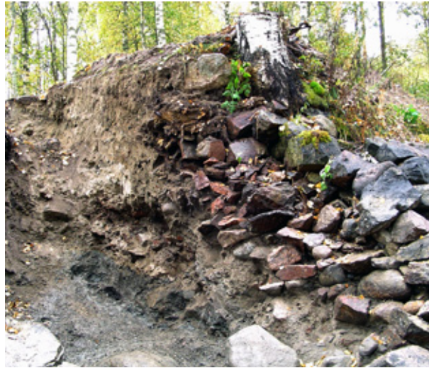
Kuva 9. Kanavan kaakkoislaidan kiviliuskan ja sen taustalla olevien maakerrosten profiili. Kiviliuskan vasemmassa laidassa erottuvat punertavat kivet ovat ilmeisesti peräisin kanavan luoteispään kallioiden louhinnasta. Kuvaussuunta: N-S.
