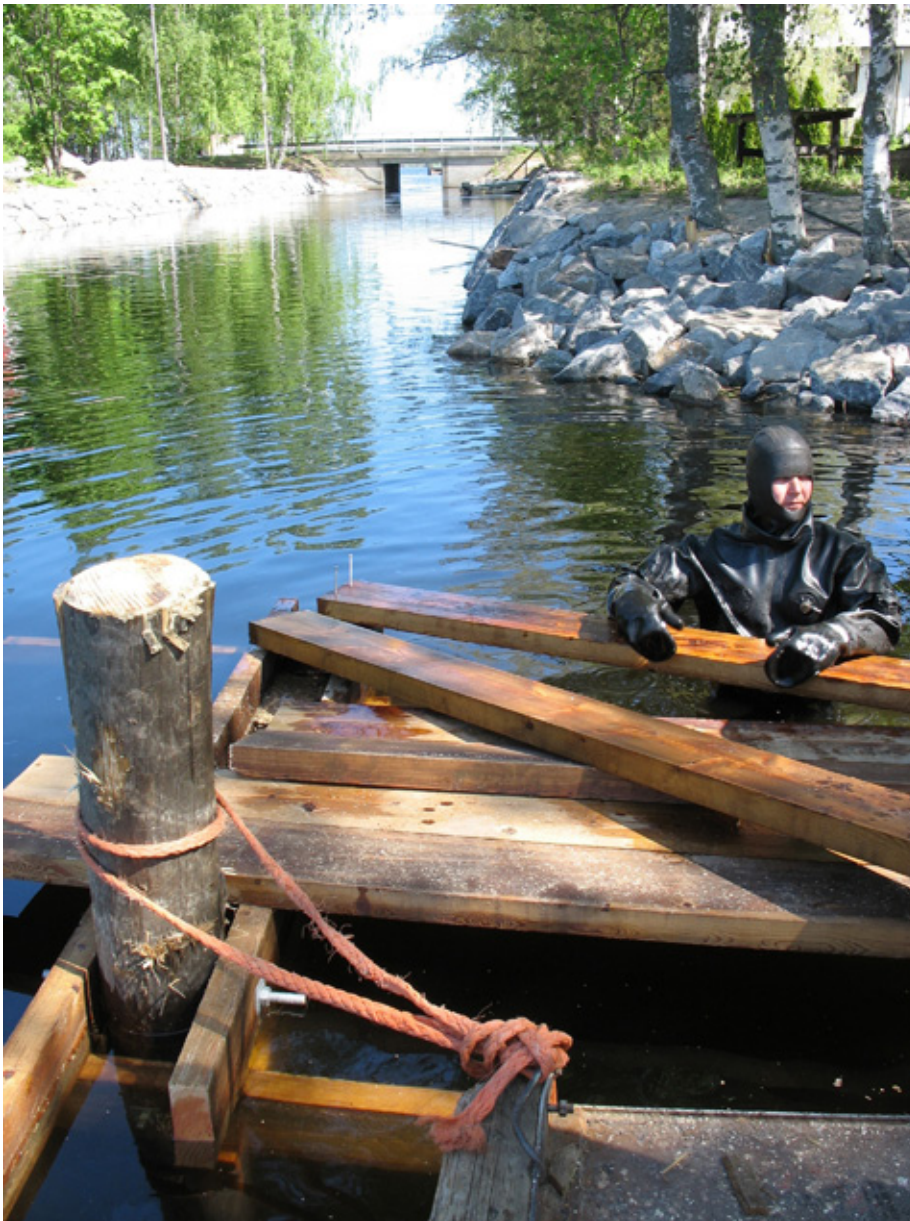
Myös laitureiden rakentamisessa tarvittiin sukeltajan työpanosta.
