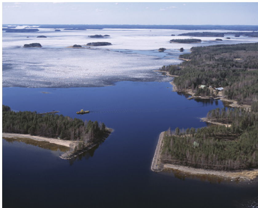
Kutveleen kanavan alkuperäiset rakenteet tuhoutuivat 1970-luvulla.
