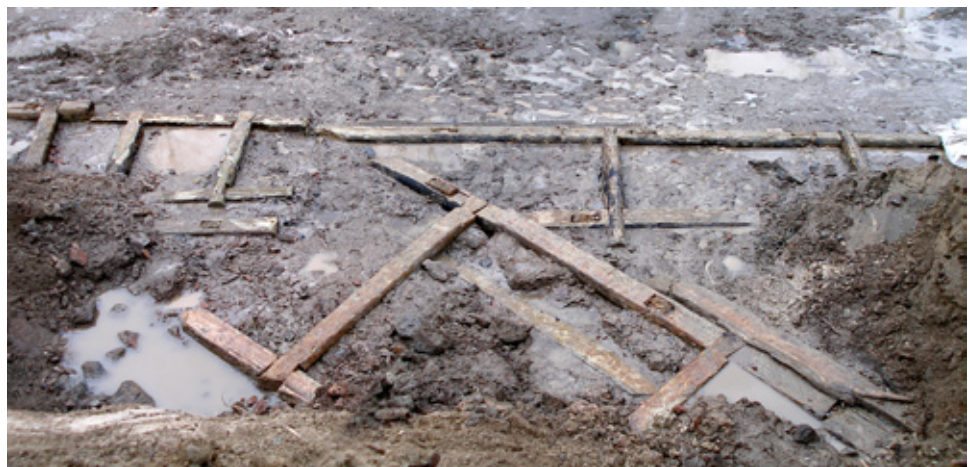
Kuva 6. Kaakkoisemman aallonmurtajan vinottainen arina. Kuvaussuunta: SE-NW.
