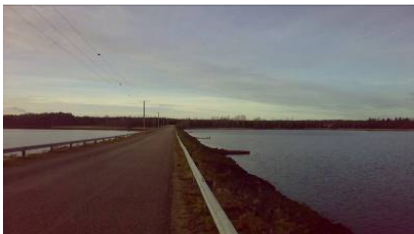
Kuva 5. Soinilansalmen pengertie marraskuussa 2011. (kuva Helena Kaittola)
