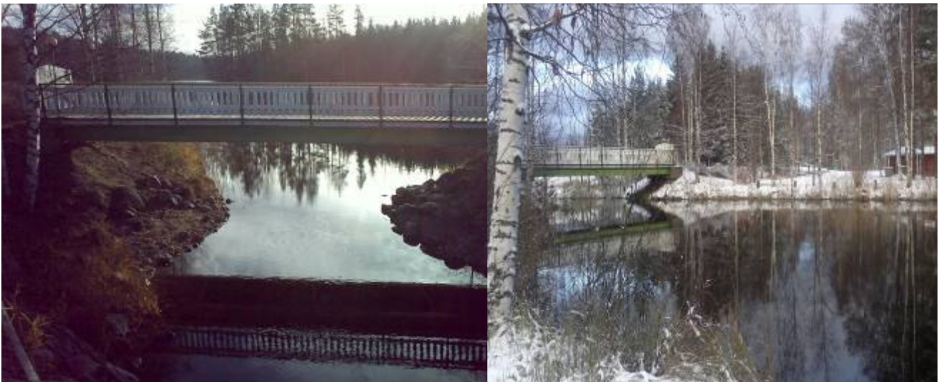
Kuva 4. Suikkalansalmen kävelysilta. Vasemman puoleinen kuva on otettu 3.11.2011 (Helena Kaittola) ja oikean puoleinen 31.10.2012 (Salme Muurikka).
