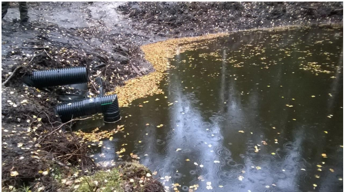
Kuva 12: Sininen Haapavesi -hankkeessa toteutettu putkipato Nauksenjärvellä (kuva: Salme Muurikka)
