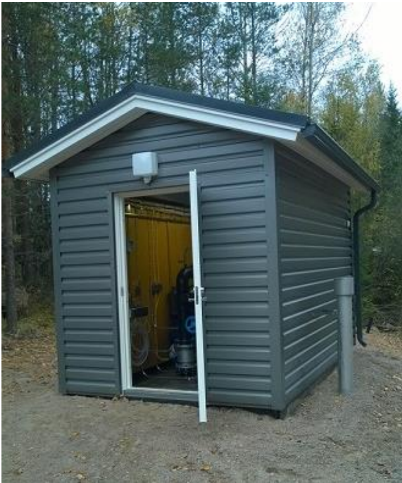
Kuva 15: Jätevedenpumppaamo (kuva: Arja Villanen)
