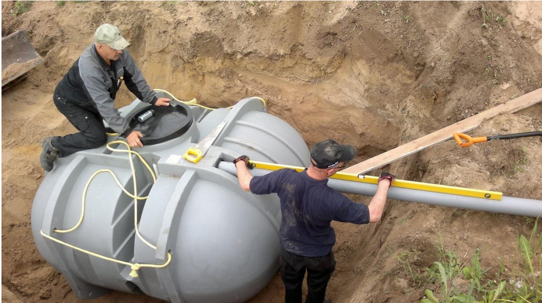
Kuva 7: Jätevesijärjestelmän vaaitusta (kuva: Marja Jääskeläinen)
